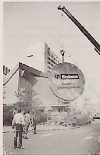
Bild 1: Montage der Satelliten-Empfangsantenne
