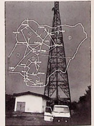
Bild 1: Bis zu 140 m hoch sind die Stahltürme für die Richtfunkstrecken in Nigeria (Siemens-Pressbild)
